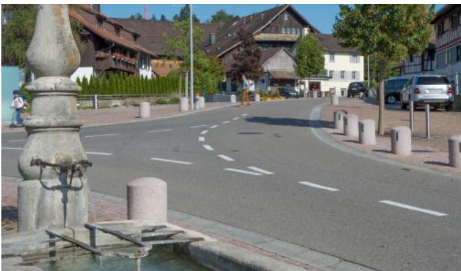
Knoten Zürcher- / Schlierenstrasse: Der Fahrbahnbereich ist auf das Notwendige reduziert. Die Bodenmarkierung verdeutlicht den Rechtsvortritt.
