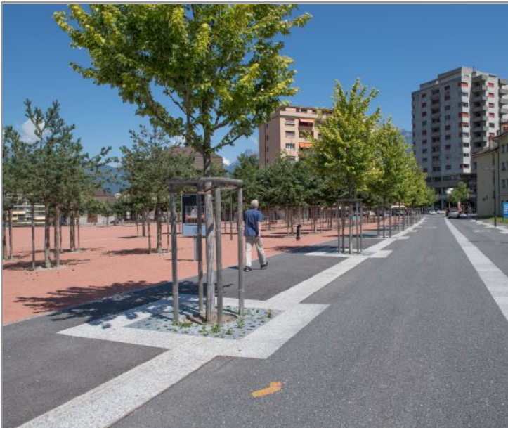
Zahlreiche Begegnungszonen wurden in Monthey bereits fertiggestellt.
