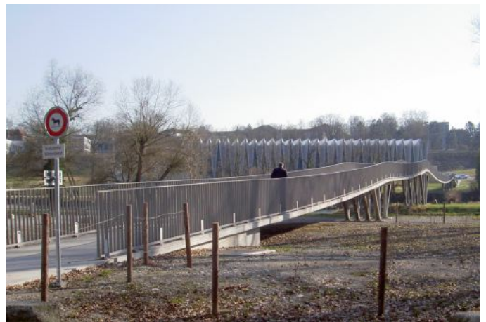
Aarestege Brugg–Windisch: Inbetriebnahme 2010
