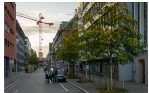
Der Baukran zeugt von der regen Bautätigkeit an der zurückgebauten Westtangente.
