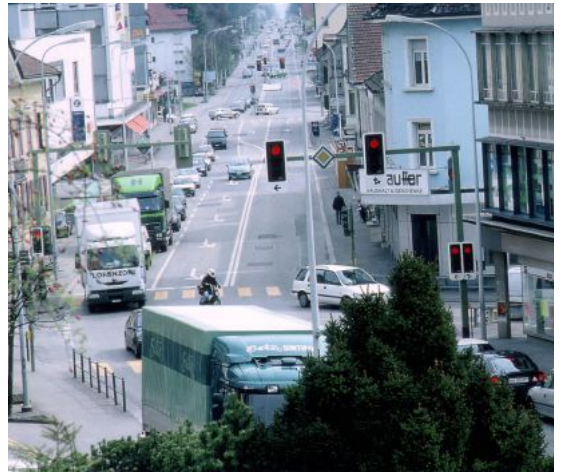
Die Solothurnstrasse vor der Umgestaltung: Eine Situation, die heute noch in etlichen Schweizer Gemeinden vorkommt.
