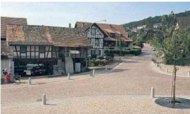
Hoffnungsplatz mit Pflästerung vor der zweiten Sanierung 2006. Quelle: Kanton Zürich
