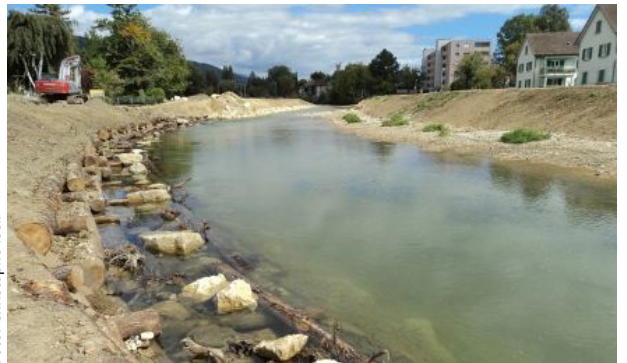
Holzstrukturen wurden entlang der Ufer angebracht und bieten geschützte Stellen für Fische.
