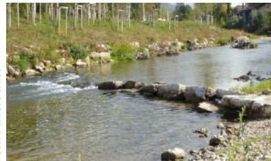
Diagonale Barrieren verändern die Strömung des Flusses und lassen unterschiedliche Wassertiefen entstehen.
