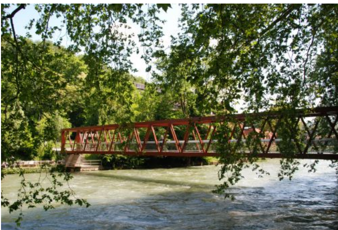
Limmatsteg Baden–Ennetbaden: Inbetriebnahme 2007
