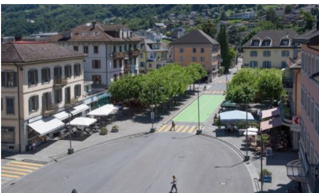
Aktuelle Aufnahme der Place Centrale: Die visuelle Einheit eines durchgehenden Belags musste wegen der Lärmbelastung aufgegeben werden. Die Pflasterung ist einem weniger lauten Asphaltbelag gewichen. Breite grüne Streifen auf der Fahrbahn sollen zum Langsamfahren anhalten.
