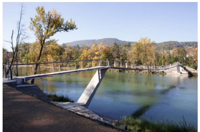
Aarestege Auenstein–Rapperswil: Inbetriebnahme 2010 (Foto: Wilfried Dechau)
