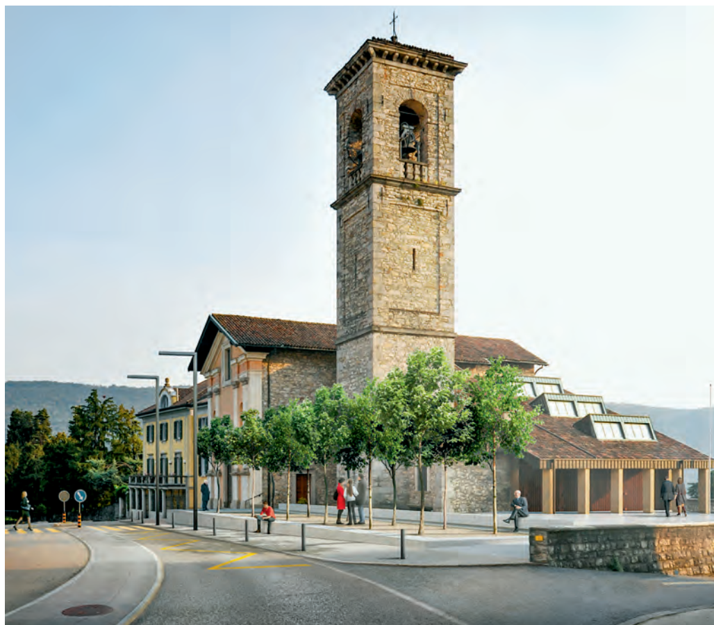
Gli alberi fanno da cornice alla piazza del paese di Vacallo, che è anche area di attesa della fermata dell'autobus. Visualizzazione: Inches Geleta Architetti
