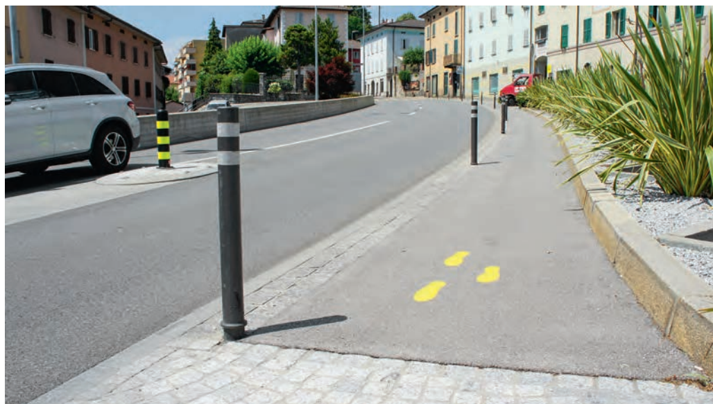
Il marciapiede è stato portato al livello della strada e i paracarri servono alla protezione dei pedoni. Foto: Monika Litscher
